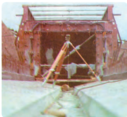
شکل ۳۰-۸- دوربین تراز یاب، سانتراژ با شاقول
