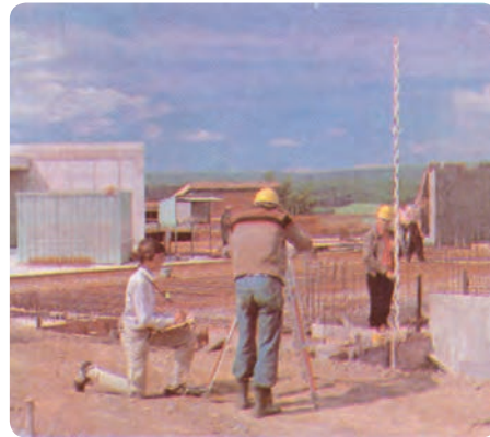
شکل ۱۴-۸- طریقه‌ی نگاه داشتن میر
